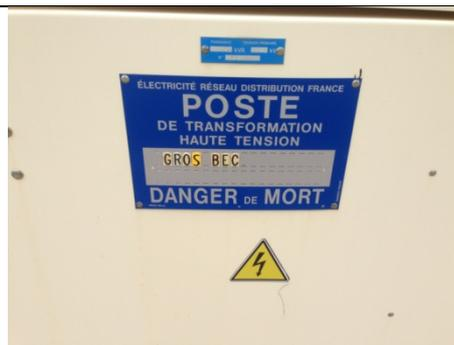
*Photo de la porte de l'armoire de coupure pour les auxiliaires (HTA/BT) avec la pancarte qui contient le nom du poste (HTA/BT).*
