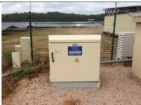
*Photo de l'armoire de coupure pour les auxiliaires (HTA/BT)*
